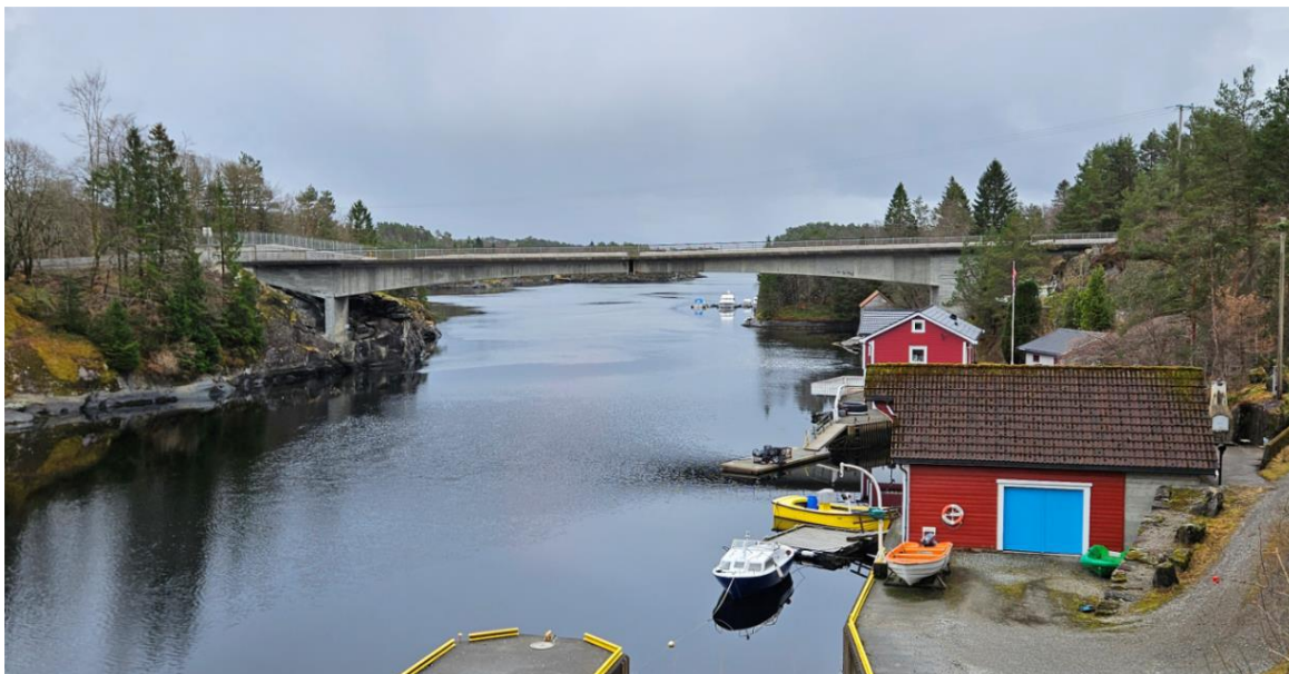
Figur 1 Dagens bru [Foto: Aas-Jakobsen]
