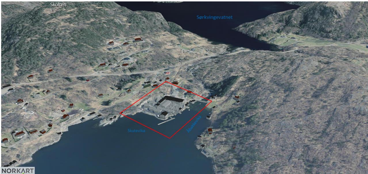
Figur 4. 3D-bilde over Settefiskanlegget til Mowi ASA på Kvingo. Fjellet Skolten (153 moh.) er synlig i bakgrunnen. Reguleringsområdet er merket i en rød firkant. Kilde: Kommunekart [5]
