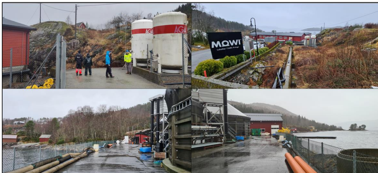
Figur 7: Foto frå anlegget.
