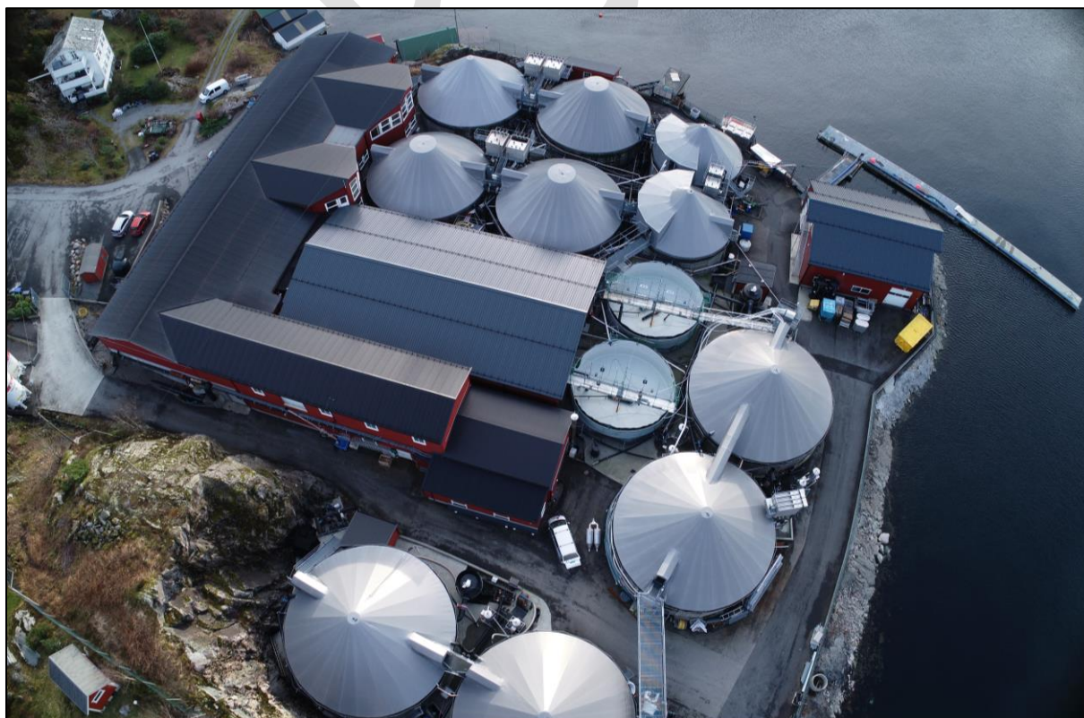
Figur 8: Dronefoto av anlegget.
